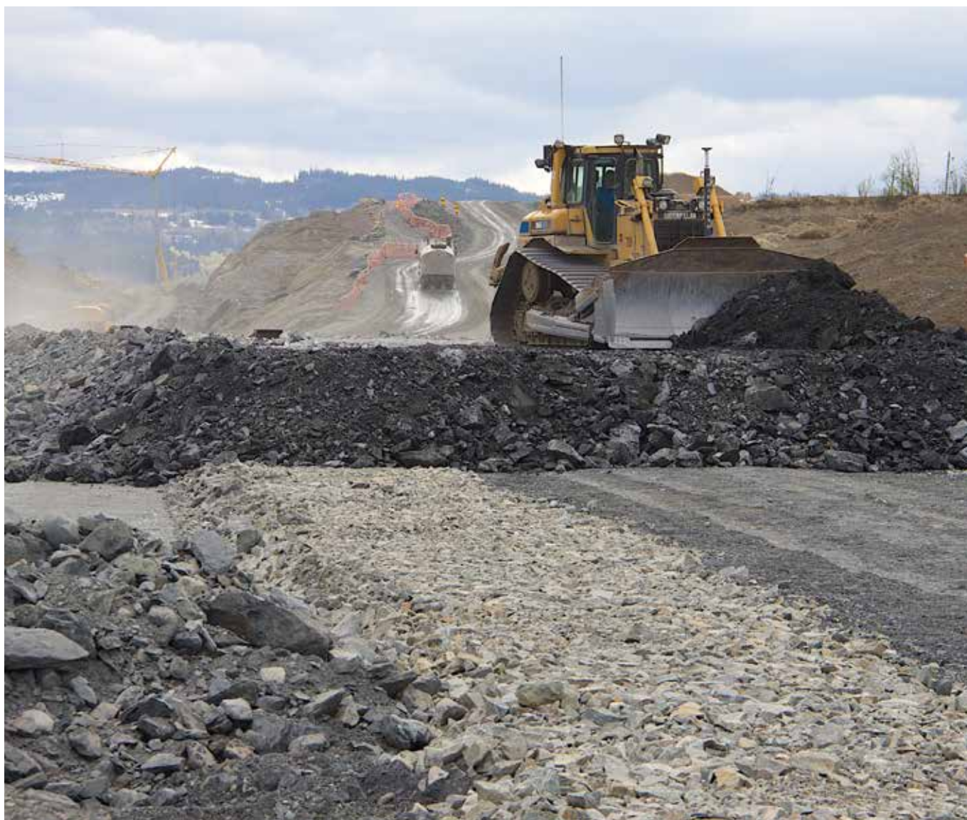
Utlegging av frostsikringslag, Gran. Foto: Frank Andersen
