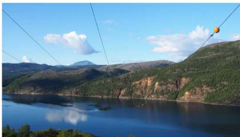
Statnett bygger linjer og transformatorstasjoner i nord, men også den nye kapasiteten er allerede reservert. Bilde: Hans Erik Opsanger
