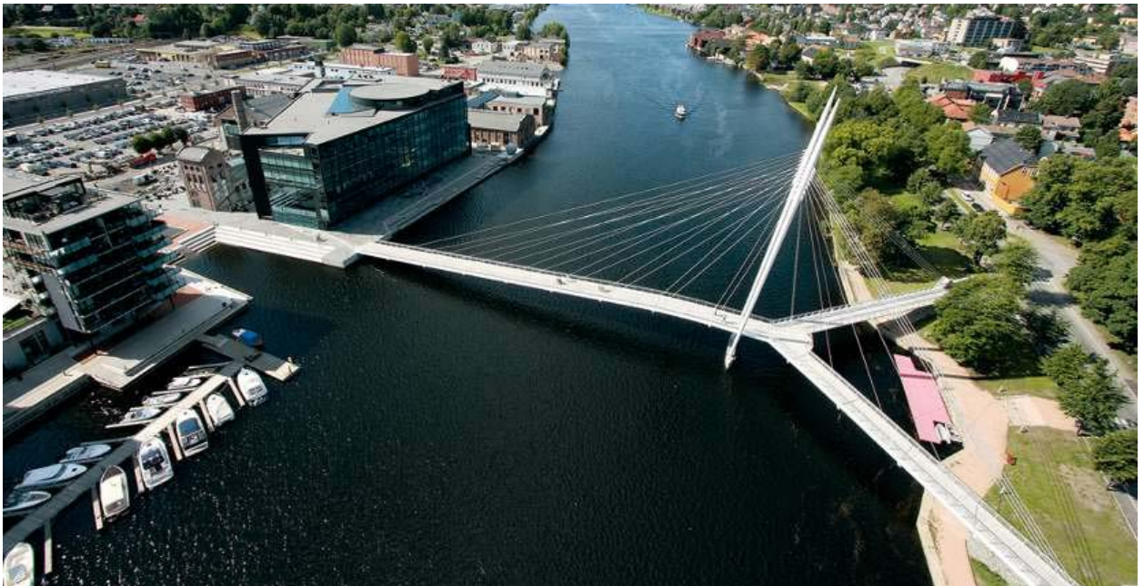
Figur 3-3: Den multifunksjonelle bydelen Grønland med boliger, arbeidsplasser og handel er etablert der tidligere papirfabrikker dominerte bybildet. Her er både boliger, kontorer, undervisningsinstitusjoner, bibliotek, kulturhus, hotell, butikker, gallerier, treningssenter, restauranter og kafeer. Gang- og sykkelbrua Ypsilon binder sammen den nye bydelen på Strømsø med Bragernes og byparken.
