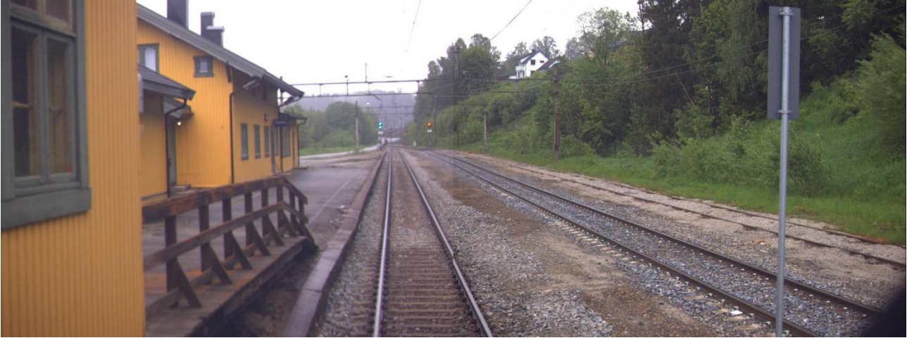
Figur 5-3 Åmot stasjon. Foto: Bane NOR
